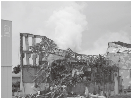
爆発後の福島第一原発3号機建屋の外観 経産省 HP より https://www.enecho.meti.go.jp/about/special/johoteikyo/fukushima2021_02.html
